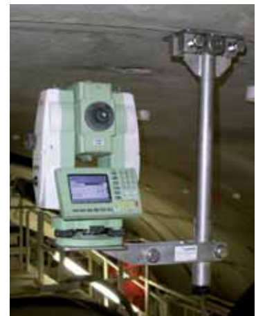
14-TK2 Überkopf-Montage im Firstbereich des Tunnels
