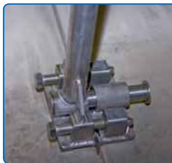
14-TK2 Detail Klemmechanismus
